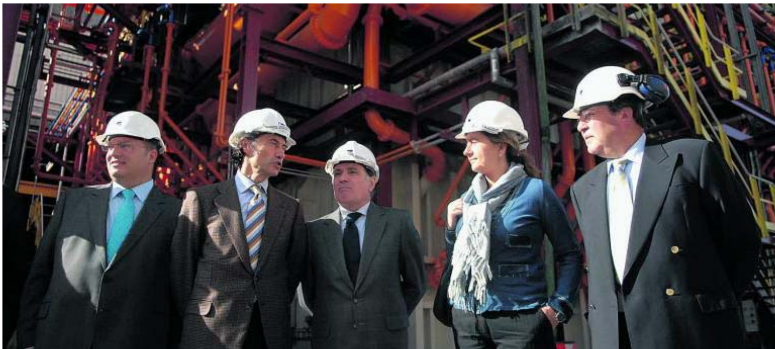
El consejero de Economía y Empleo, Tomás Villanueva (centro) en su visita a las instalaciones de la Central Térmica de Compostilla. GAZTELU
