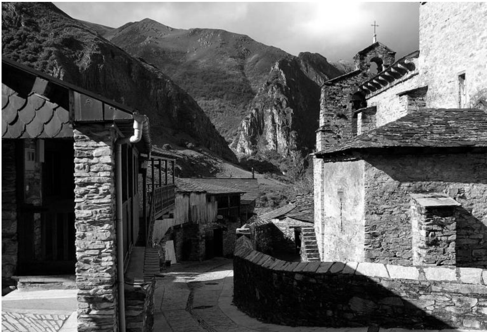
Los vecinos de Peñalba de Santiago denunciaron ayer la instalación de antenas parabólicas que degradan este entorno declarado BIC. GAZTELU
