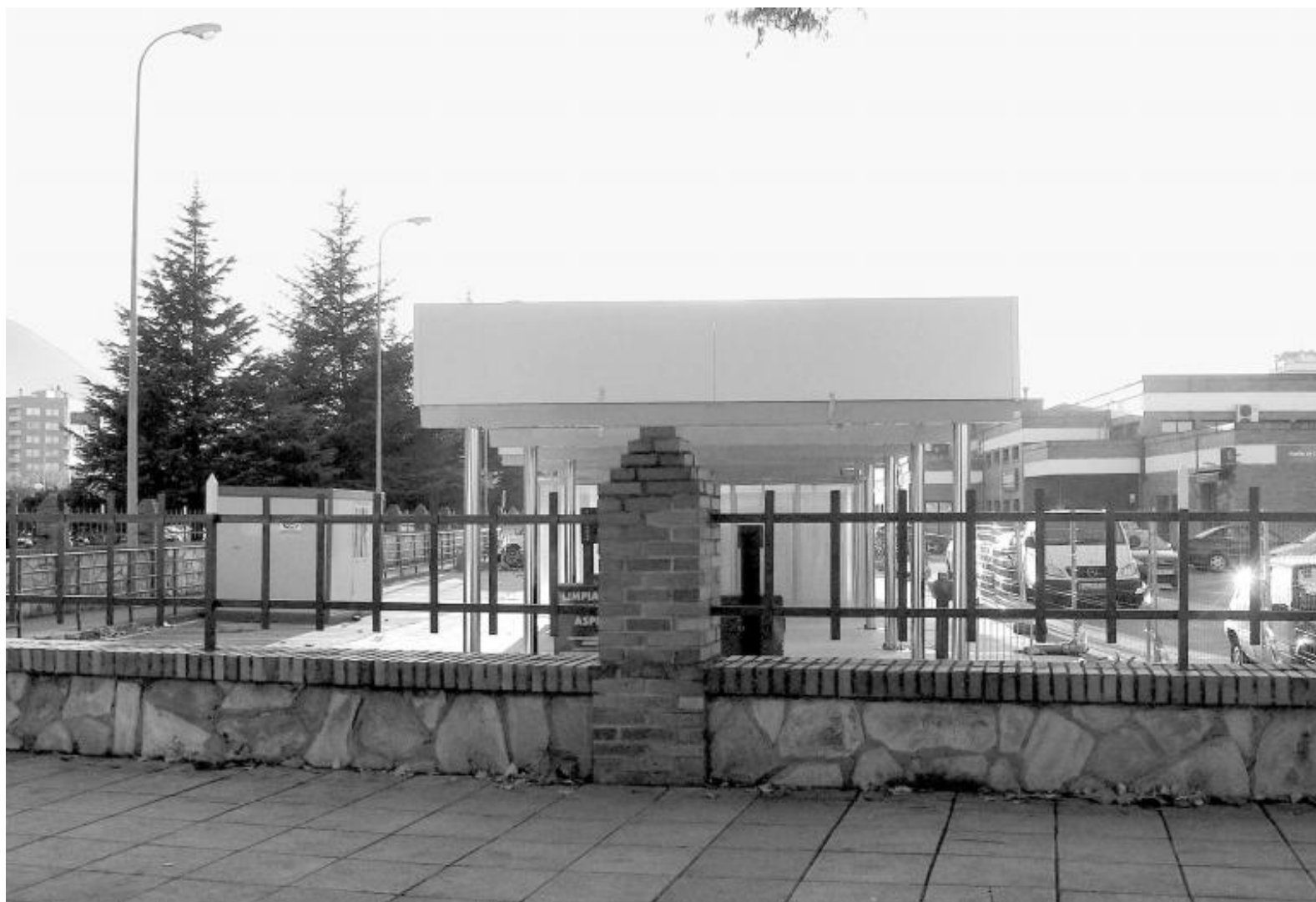
El lavadero de coches de la estación de autobuses deberá ser demolido por infringir la normativa urbanística. A.R.L.
