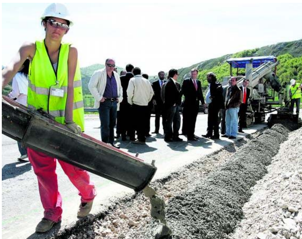
Antonio Silván en las obras de la carretera autonómica CL-635 que une Burón con Asturias. CARLOS S. CAMPILLO
