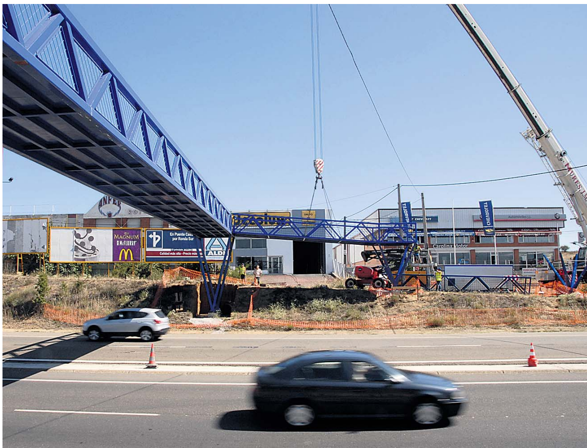
Una grúa trabajaba ayer en la colocación de la pasarela para los peregrinos. MARTA LÓPEZ
